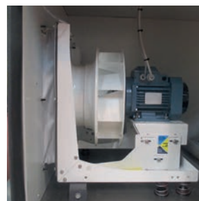
Roue libre avec moteur asynchrone
