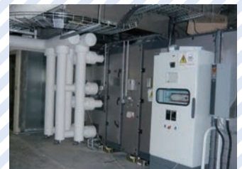
Centrales de traitement d'air remontées.
