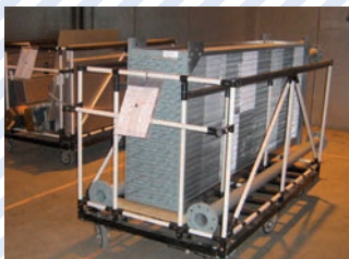
Centrales de traitement d'air démontées sur chariots spécialement créés.
